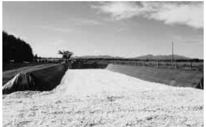
計根別農協管内に設置された簡易堆肥施設。ビニールシートと貝殻で施工された施設の事例
