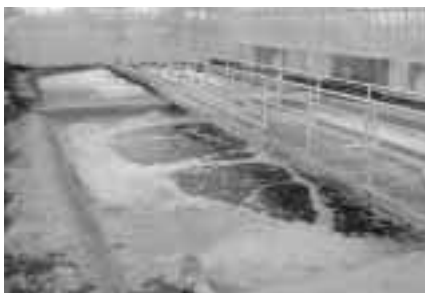
ハウスで保温効果を高め、微生物の活性化を 促進させた自然浄化システム
