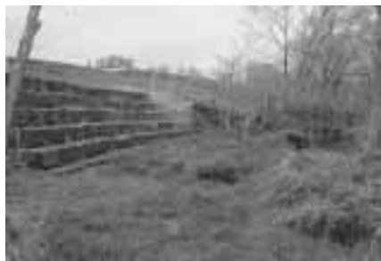
パドックからの糞尿流出を防ぐ ホタテ貝殻を詰めたブロック
