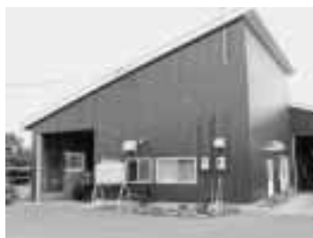
処理室周辺も花とアスファルトで環境美化
