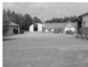
施設周辺も整備され、作業性の高いスペースに…
