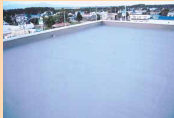
▲防水工事完了
