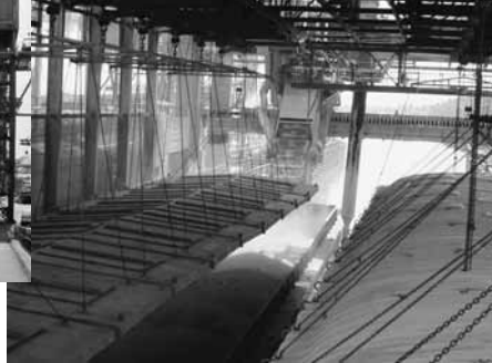
バージはしけから荷卸している様子
