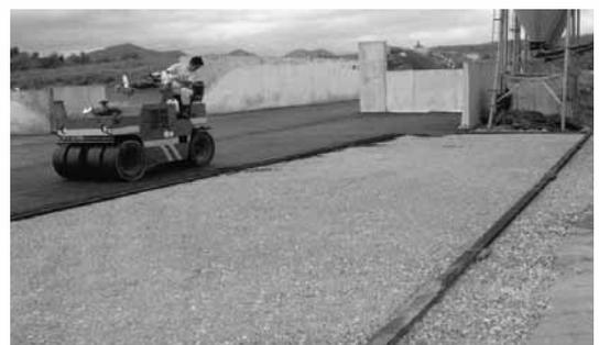
写真2 アスファルト施工の様子
