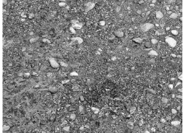
写真1 バンカー床面に小石が浮いてきている(利用5年目)
