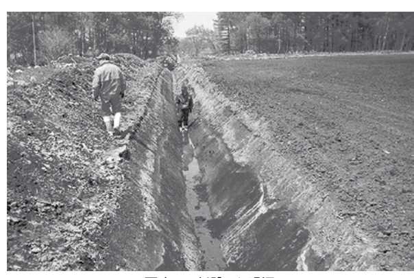
写真1 新設した明渠
