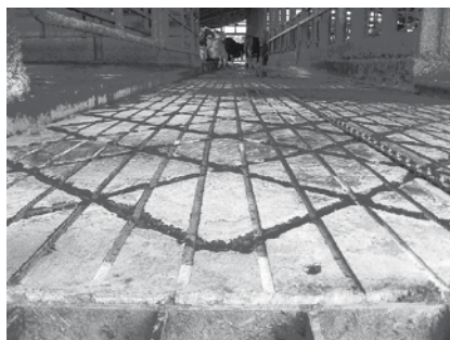
写真3 右写真の施工後の状況
