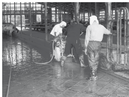
写真2 既存のダイヤモンド目地に専用機でストレート目地を施工する様子
