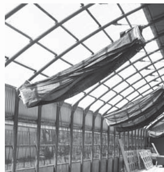
写真2 寒冷紗で採光量を調節できるほ育舎
