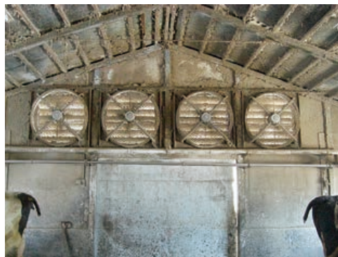
写真1 常時、換気扇をゆつくり回して排気する
