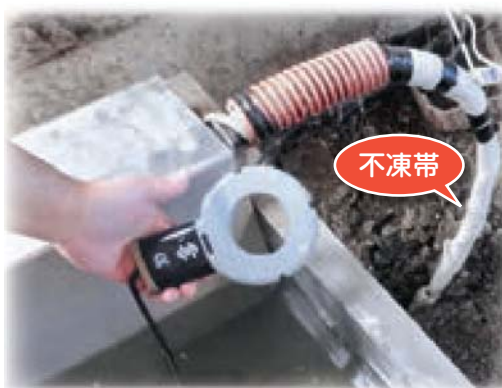
不凍帯をホースに巻き、電熱線を入れた
