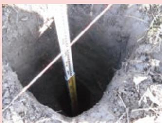
写真2 ③縦孔暗きょの施工
