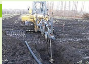
写真4 カッティングドレーン施工
