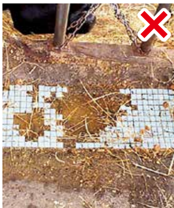
残飼放置・タイル破損
