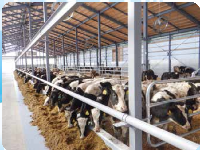
稼働後の様子
