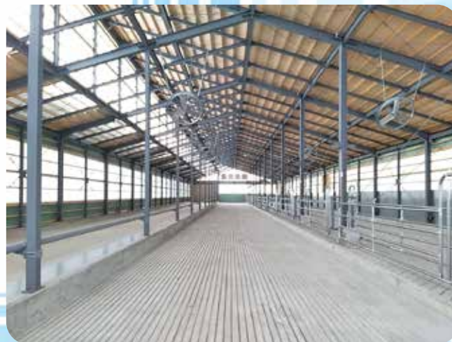
完成した牛舎内部
